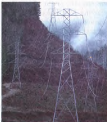
Опоры линий электропередачи
